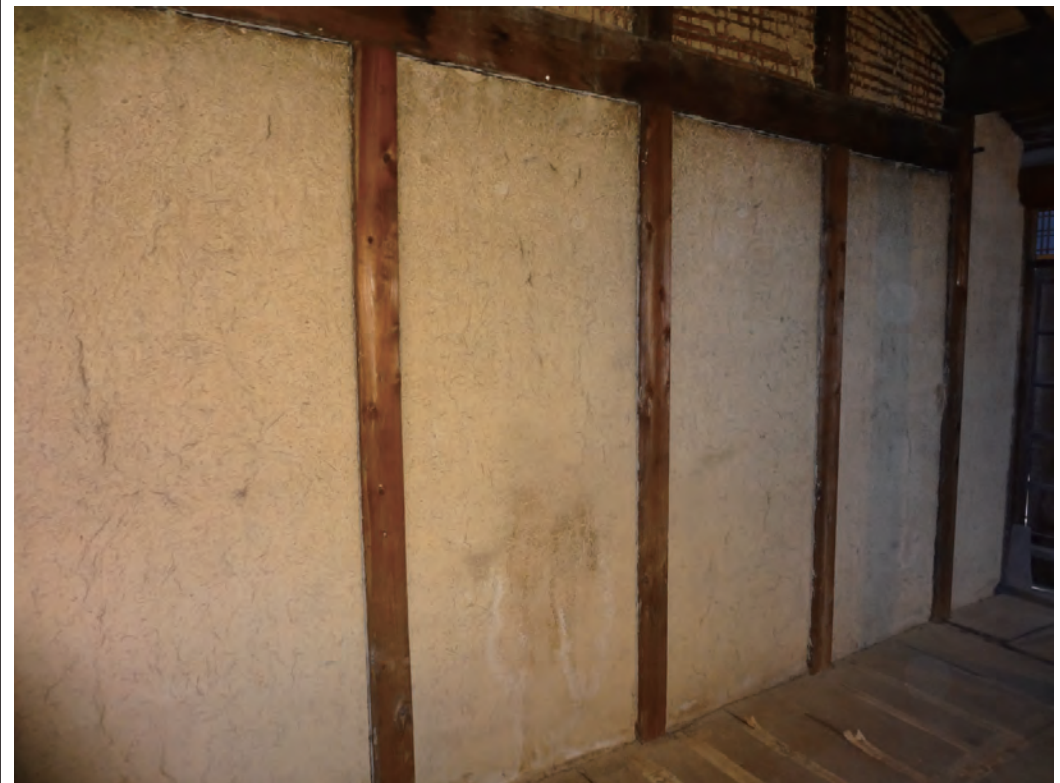
2階北側の既存の土壁
