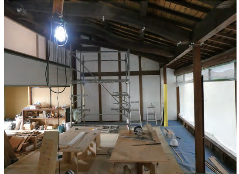
漆喰下地塗り
