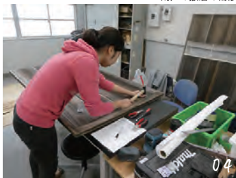
04 雨戸の釘を打ちなおす
