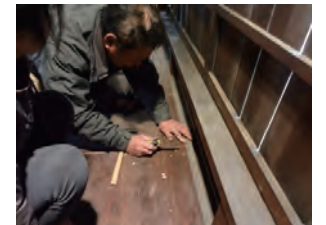
床板の端は脳天打ちした後にダボを打つ
