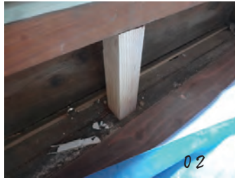
02 新たに束を設置し雨戸下を区切る
