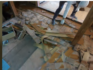
2階中廊下床の解体
