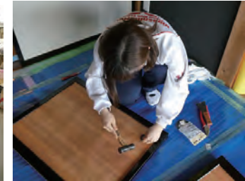
襖の引手を設置
