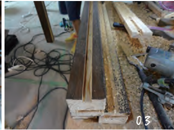
03 障子の枠を設置するためのレール
