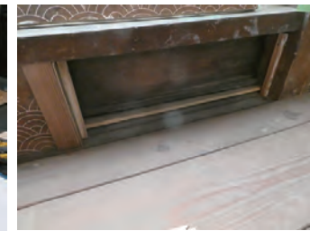
受け材の作成・固定
