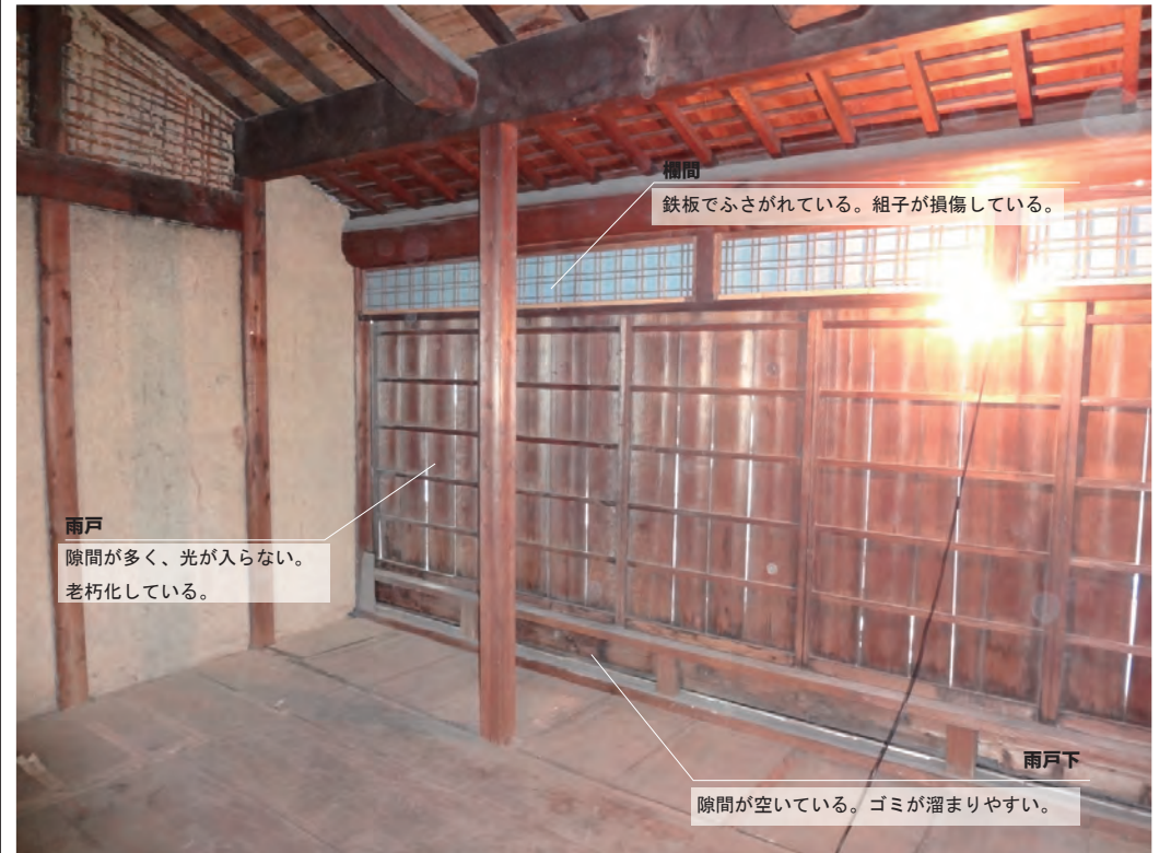
2階大広間の建具（改修前）
