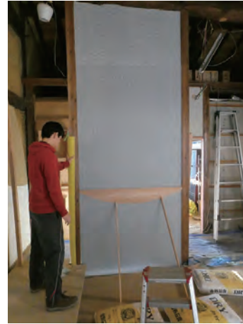
固定した下地の上に船型の木材を貼りつける
