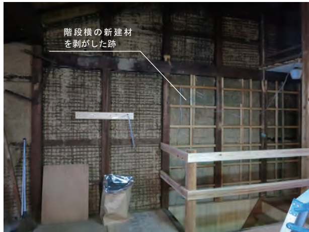
2階南側の既存の土壁
