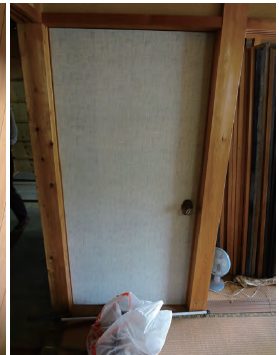
8帖和室から見た扉（改修前）
