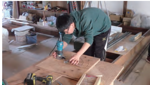
青海波の型枠作り (試作)
