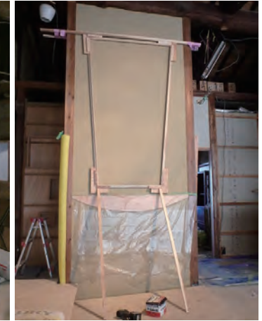
帆の部分の型枠を作成
