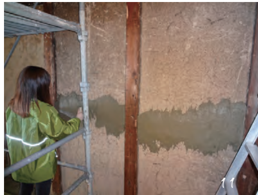
貫の部分に藁で補強する（貫伏せ）
