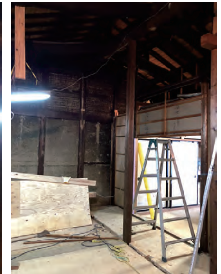
不安定な柱と梁を取り除いた
