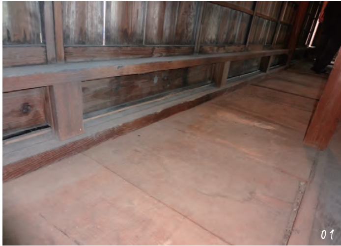
01 既存の雨戸下部分
