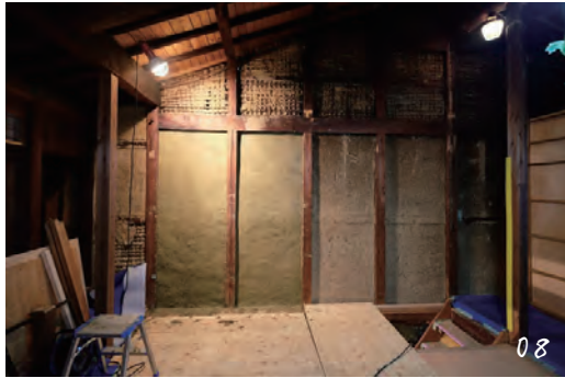
2階南側の下塗り（途中段階）
