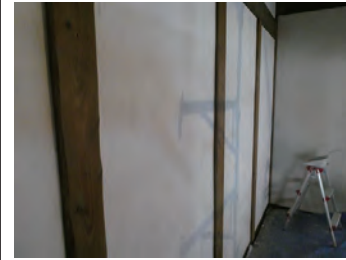
漆喰ベースが塗り終わった状態
