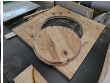
青海波の型枠作り (試作)
