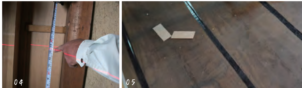
レーザー墨出し器を使用し床の傾きを調べる
