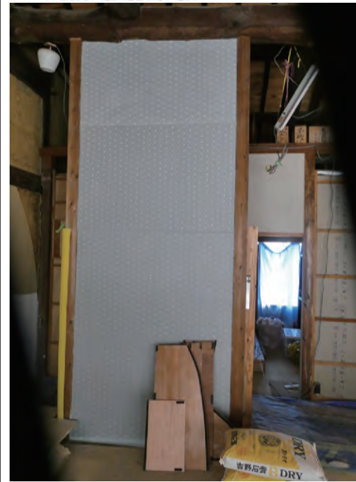
ラスボードの施工
