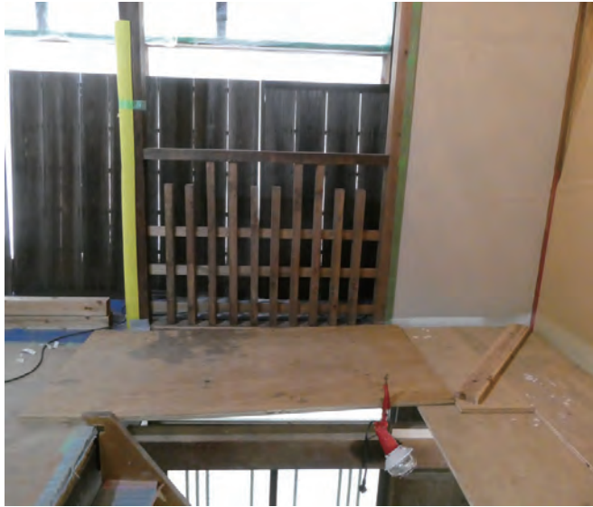
試作の手すり
