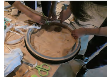
明り取り窓の仕上げ
