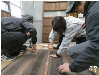
07 雨戸に目板を固定
