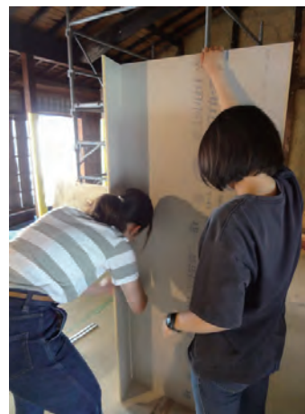
石膏ボードはカッターでカット
