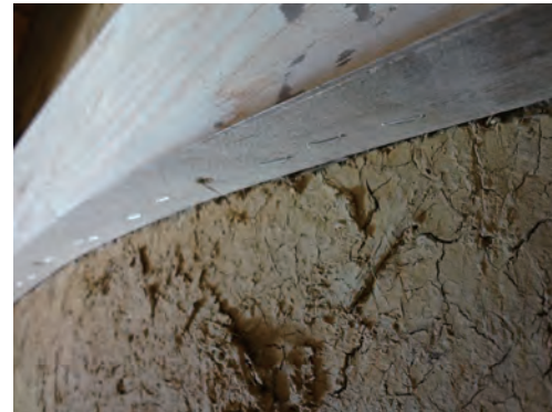
大山の型枠を設置する
