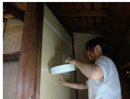
石膏ボードの境目をテープにより埋める
