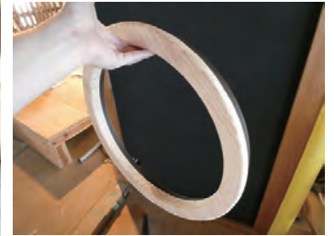
明り取り窓の枠の作成
