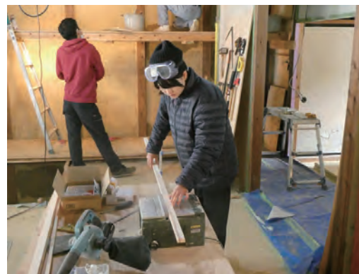
欄間のアクリルを固定する枠パーツを作成
