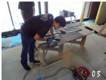
03 吹き抜け部分の床材を再利用
