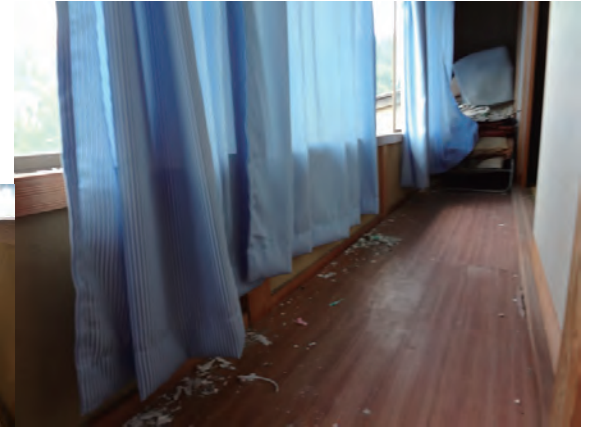
改修前の縁側廊下
