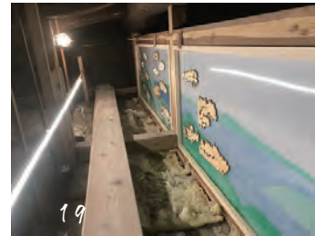
19 天井裏に設置
