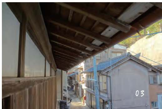
既存の欄間 (外側は金属板が貼ってある)
