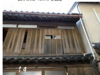
11 試作の雨戸に木枠を固定
