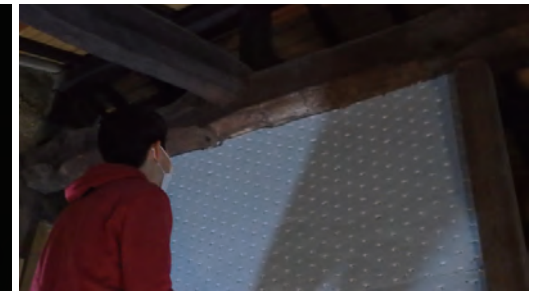
梁の形に合わせてラスボードを整形
