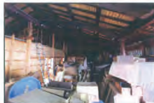
写真.5 改修前2階大広間
