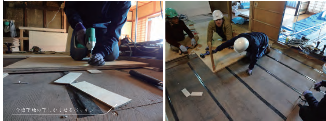
下地の24mm合板をバッキンでレベル調整しながらビスどめ
