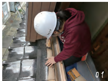
01 雨戸の敷居の補修
