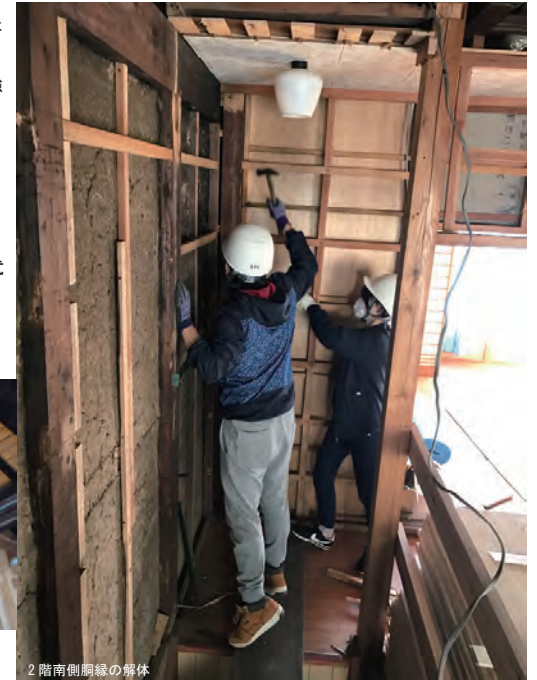
2階南側廊縁の解体
