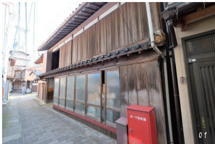
青石畳み通り側から見た外観 (2階建具)
