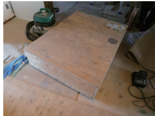
階段1段目の土台
