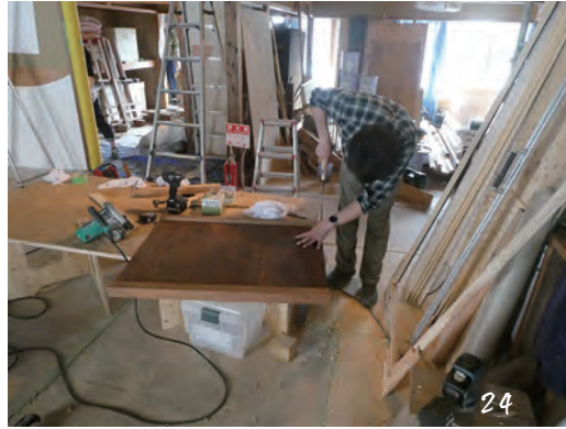
24 点検口の作成 (床板を再利用)
