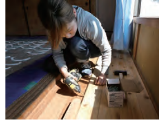
フローリングの固定
