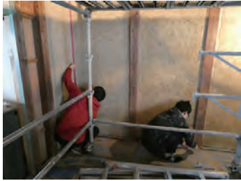
マスキングテープを柱に貼る
