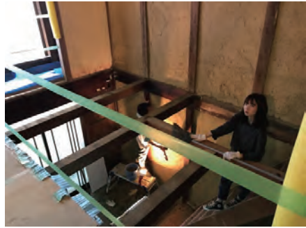
床板を撤去し吹き抜けとした
