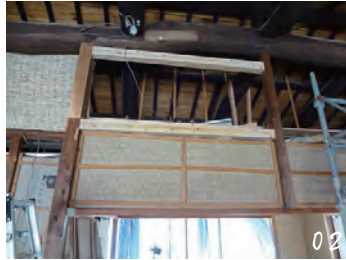
02 障子を設置するための鴨居・敷居の作成
