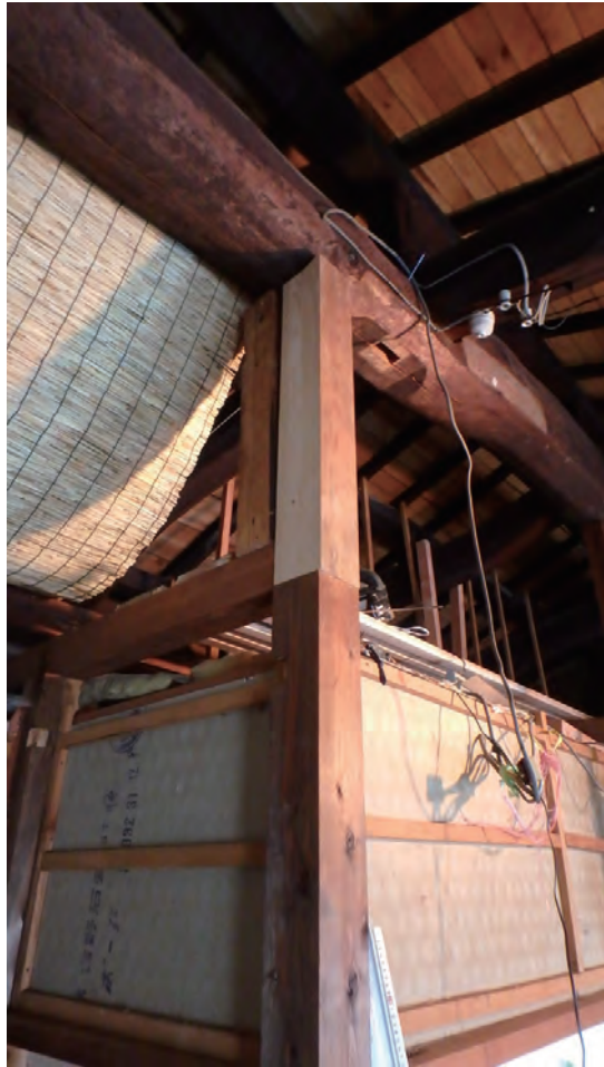
柱の補強・新設
