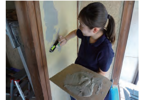
漆喰用の下地としてスーパーカーボンプラスターを塗る
