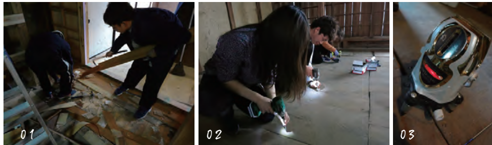
2階廊下の床材を解体
