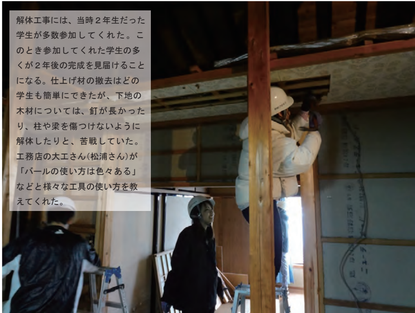
2階廊下天井の解体
