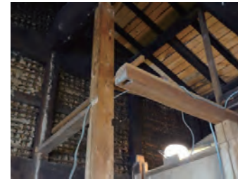
解体したことで見えてきた柱と梁
