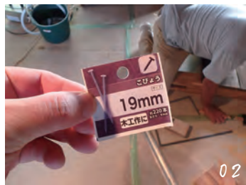
02 雨戸の補修に使用したこびよう
