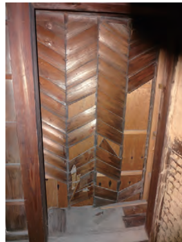
解体前の戸袋
