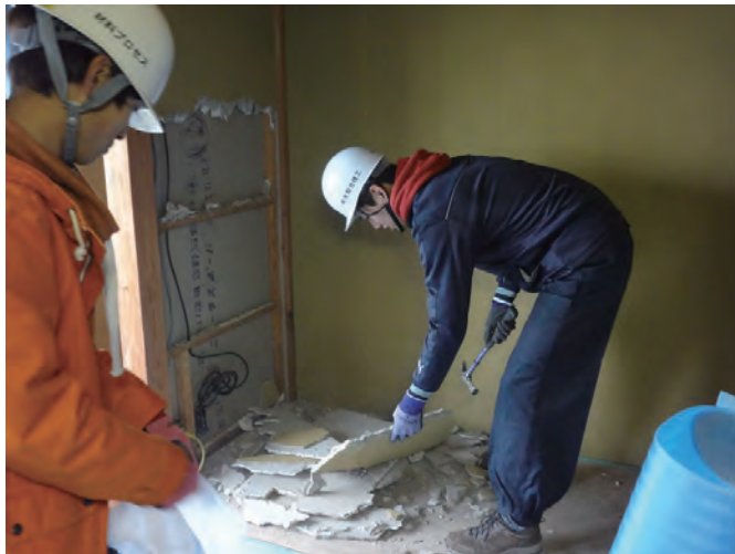
2階床の間壁の解体
