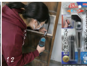
12 木枠の固定にはアングルドライバーを使用した
