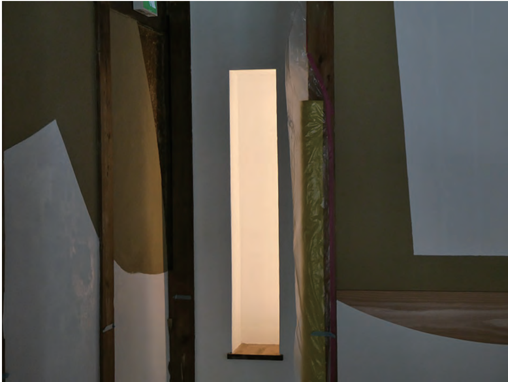
完成したニッチ
