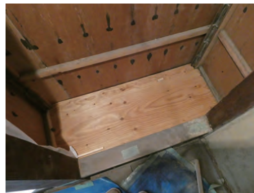
戸袋の底板の補修
