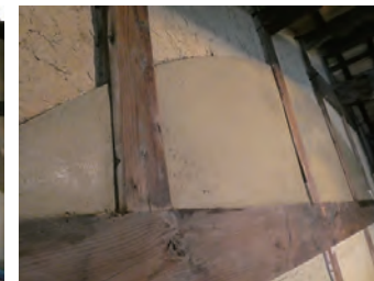
型枠を外した状態
