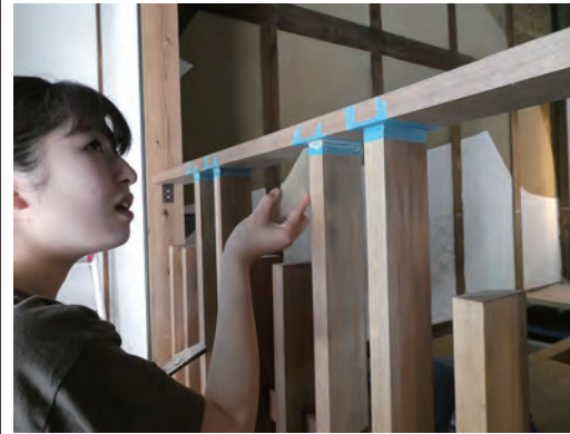
手すり子と笠木の隙間を補修
