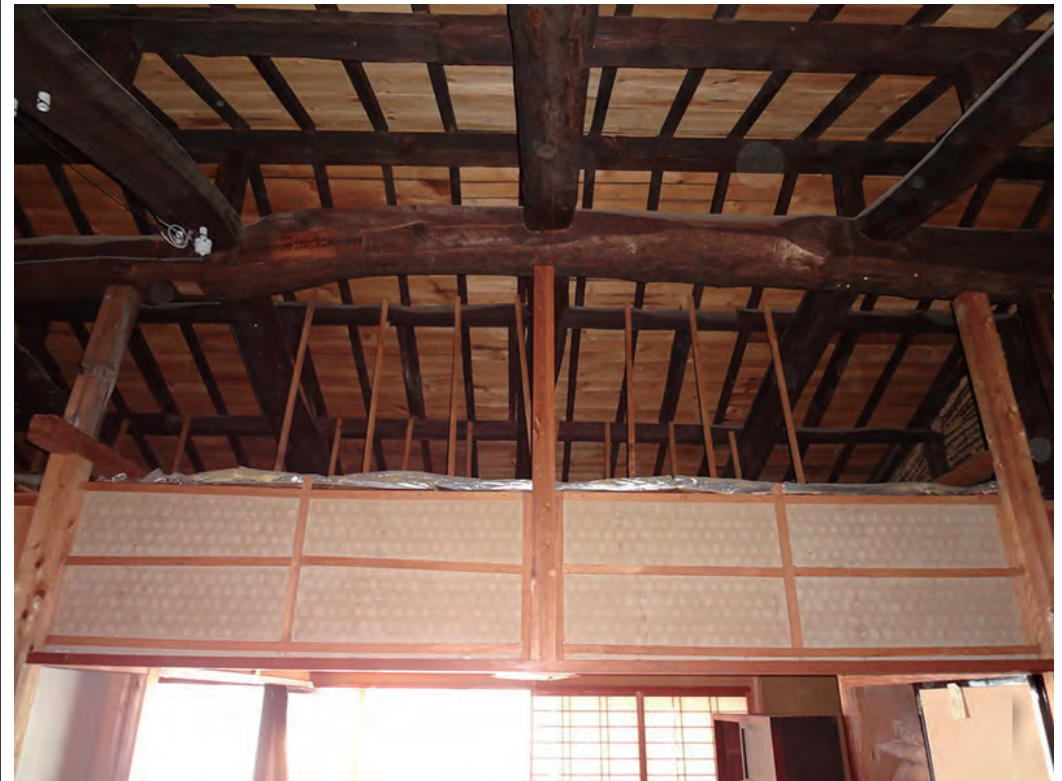
改修前の天井裏
